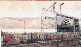
Wird Bestandteil des neuen Viertelzentrums: Ein moderner Neubau des Traditionsgeschäfts Schlafzimmer Stephan.
